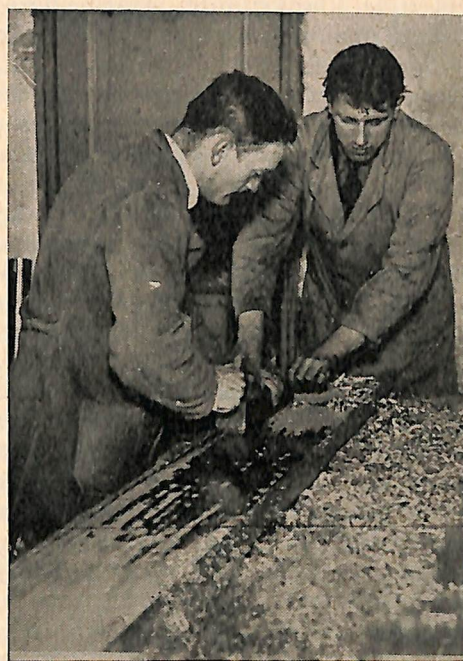
Hier worden tinnen platen met de handschaaf op de vereiste dikte gebracht. (Jac. Stinkens links).
